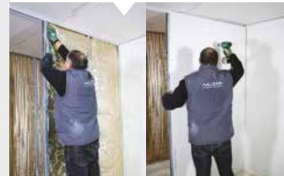
**6** Installare i pannelli di cartongesso sull'altro lato del tramezzo. Iniziare con metà pannello in modo che i giunti dei pannelli vengano inseriti in montanti diversi da quelli dalla posa dei primi pannelli.
