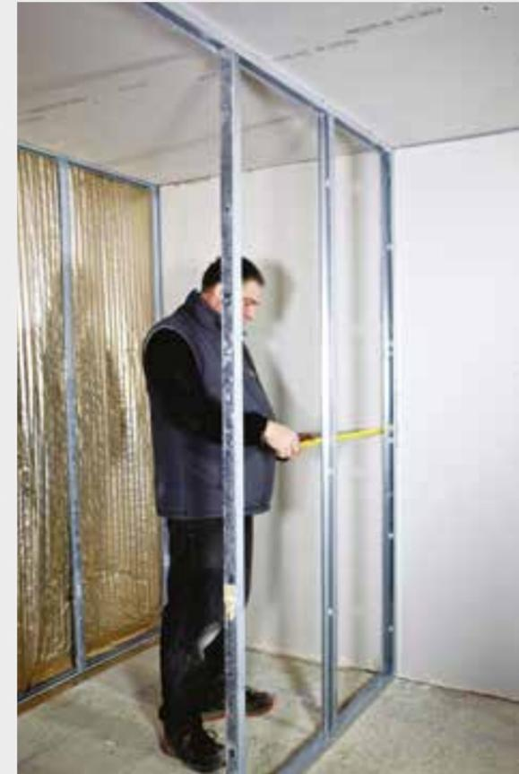
**1** Installare la struttura in metallo conformemente alle regole vigenti.
