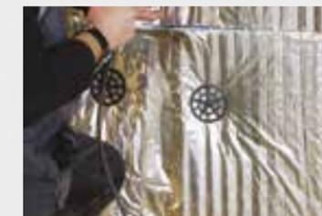
**Caso particolare:** In caso di installazione in un muro alto > 2,70 m, tenere i pannelli della prima fila contro la muratura servendosi di 2 tasselli in nylon a rosone per ogni pannello, da posizionare nella parte superiore. Poi mettere la seconda fila di pannelli in verticale sulla prima tenendola ferma con 4 tasselli in nylon a rosone per ogni pannello.
