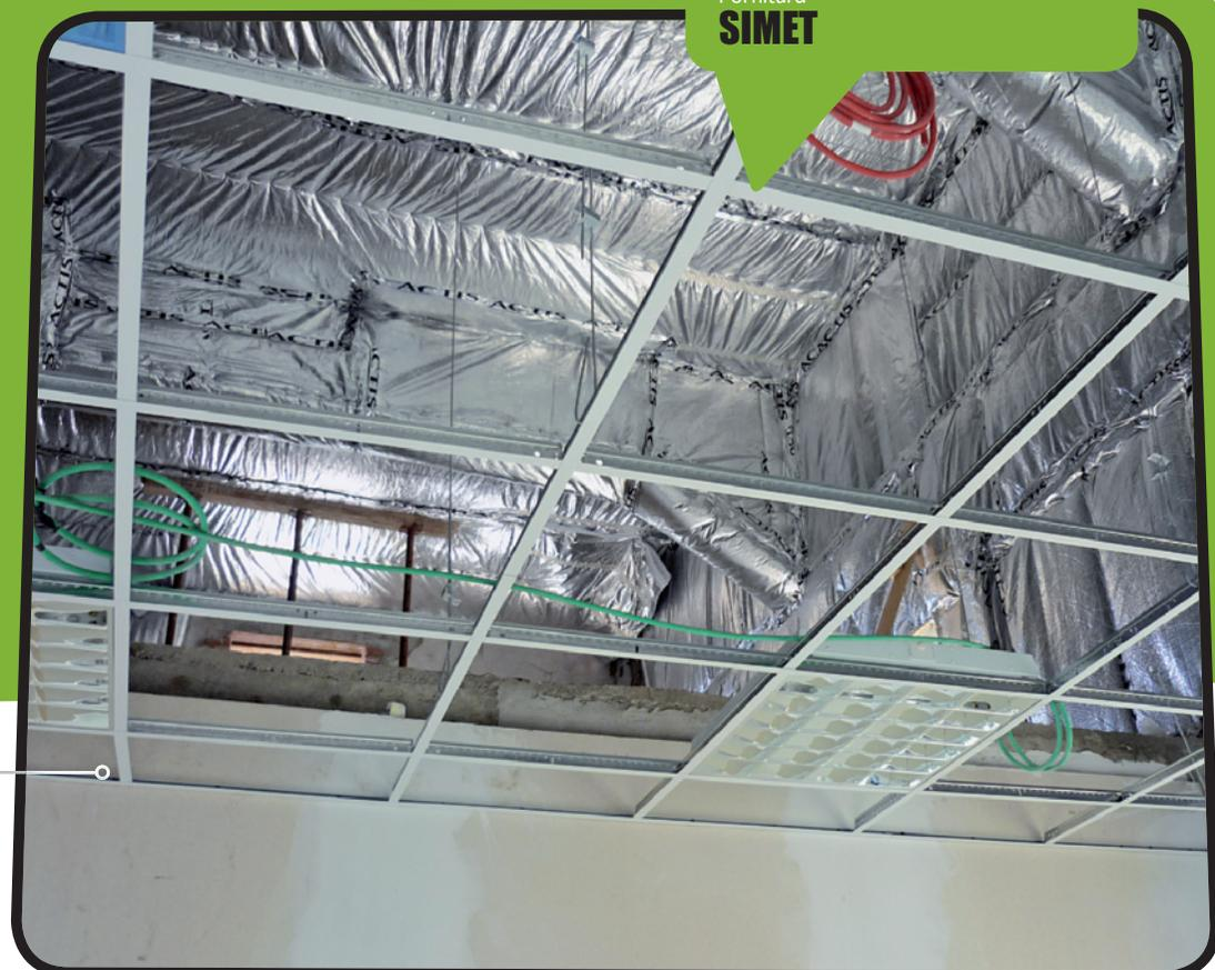
Il multistrato termoriflettente Triso Super 10+ è stato posato lasciando le necessarie intercapedini di aria ferma su entrambi i lati. Per minimizzare le dispersioni, specie in corrispondenza dei ponti termici, è stata posata una controstruttura
